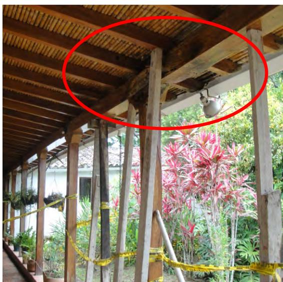
**Figura 8.** Edificio A2. Pudrición de viga solera del corredor A-16
