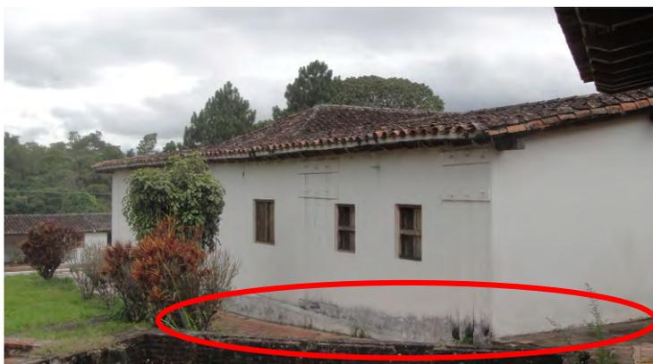
**Figura 9.** Edificio A2". Humedad por capilaridad y suciedad en cara externa de muros.
